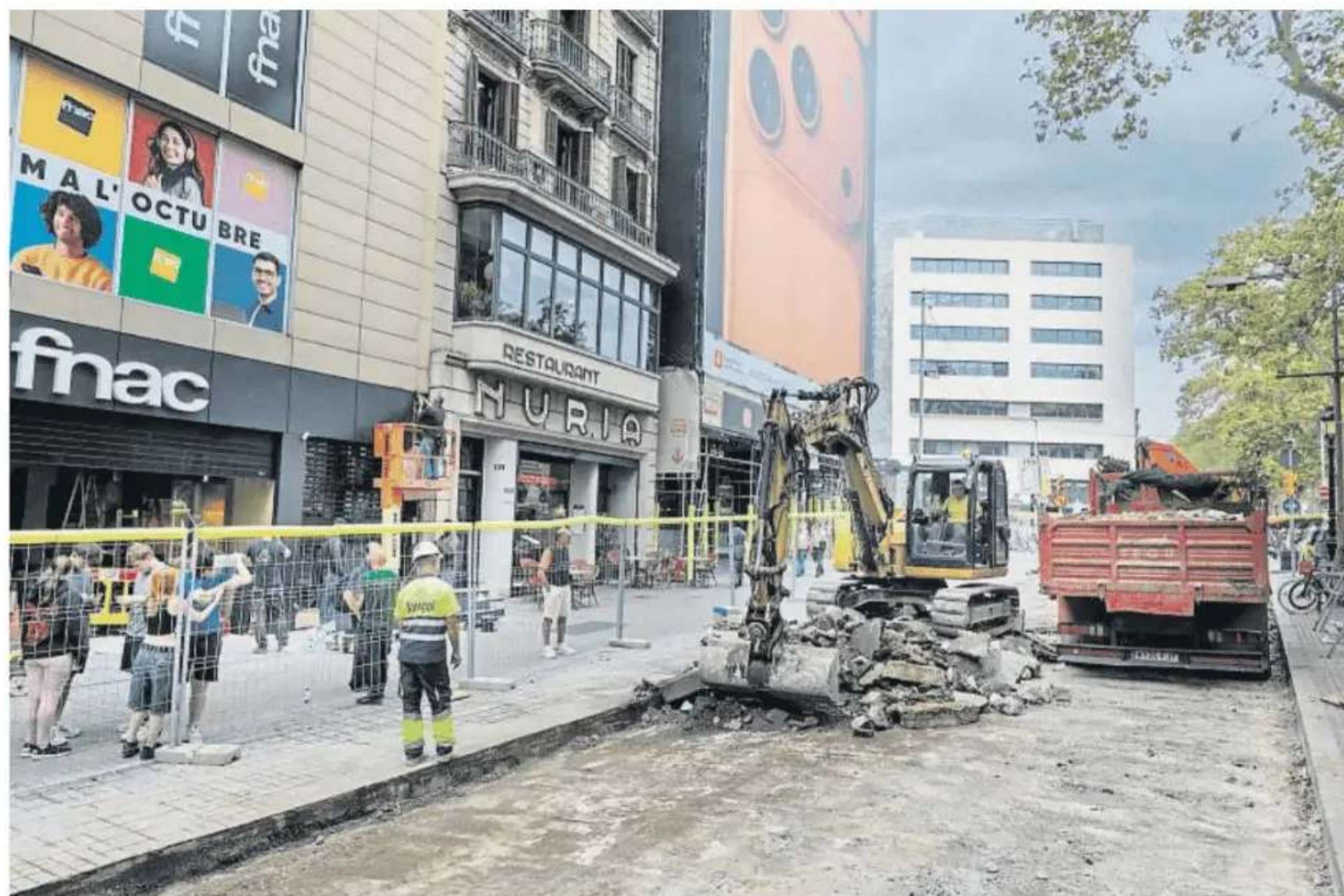
El proyecto de la Rambla, uno de los que bebe de los presupuestos del 2026. En la foto, las obras, ayer, junto a plaza Catalunya
